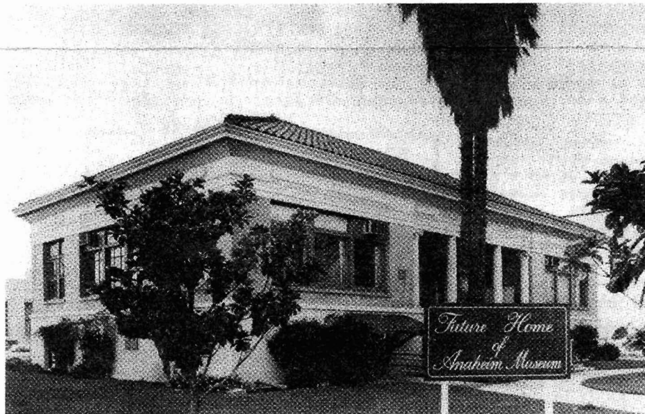
Anaheim Carnegie Library
